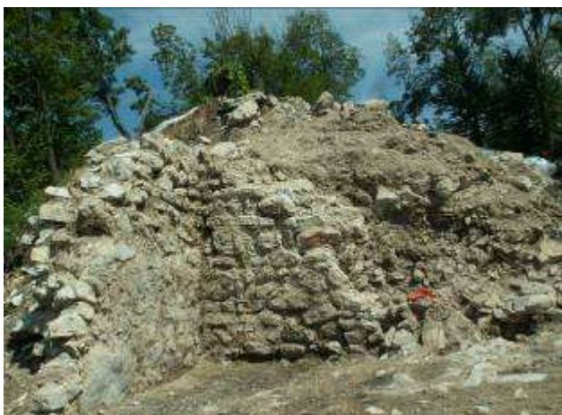
Muri romani sul lato Ovest
