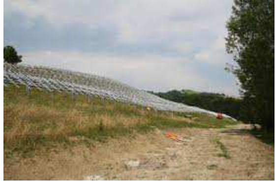
Strutture per modulo fotovoltaico in scarpata
